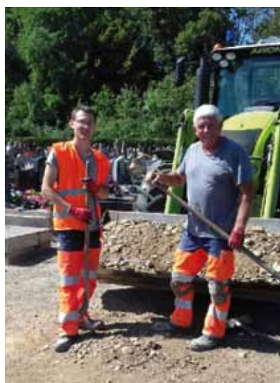
Léo LAMBERT - Pôle maintenance des bâtiments (Juillet)
